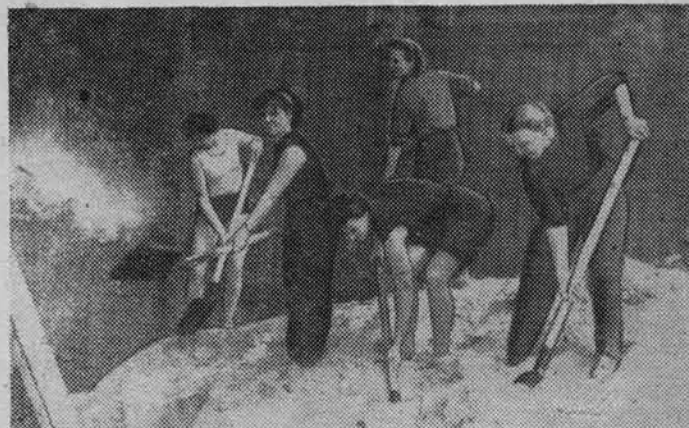
На строительстве стадиона с каждым днем все шире разветвляются ремонтные работы. На снимке: студентки 6 гр. II к., 2 и 4 групп III к. педфака работают на стадионе.
