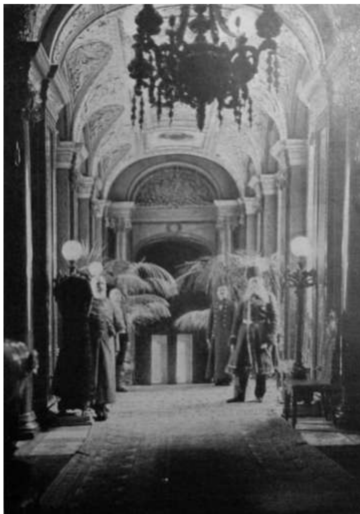
Главный вход (или горе студенту, опоздавшему на первую пару!)
